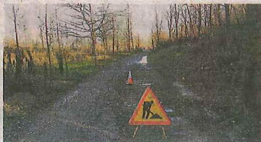
Tramo de la Vía Romana del Iregua de Villamediana, en obras. D. M. A.
